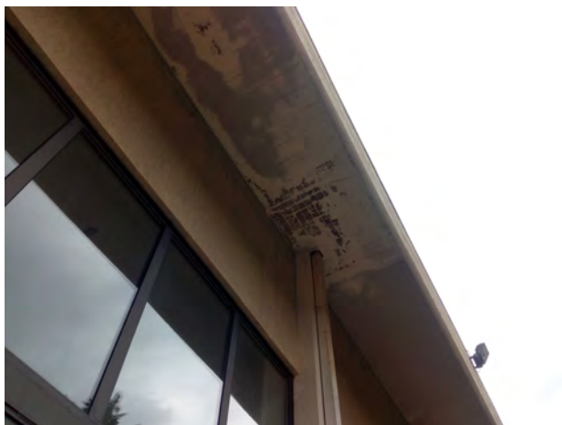
Solette di copertura a sbalzo in c.a.
