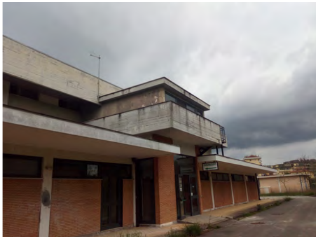
Velette in c.a. di copertura
